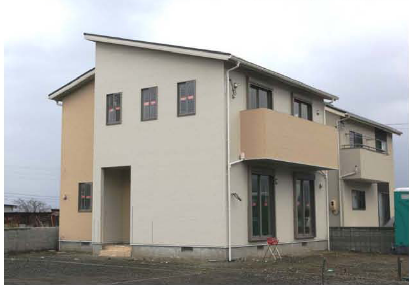
やさしい色使いの外壁
